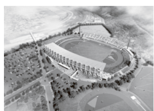
三重交通G スポーツの杜 伊勢 (陸上競技場) 完成イメージ …外観は神宮の社殿や宇治橋の橋脚をイメージしたデザイン
